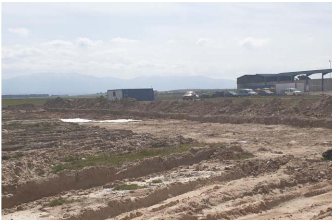
Al fondo donde se encuentran los vehículos se construirá la nave
