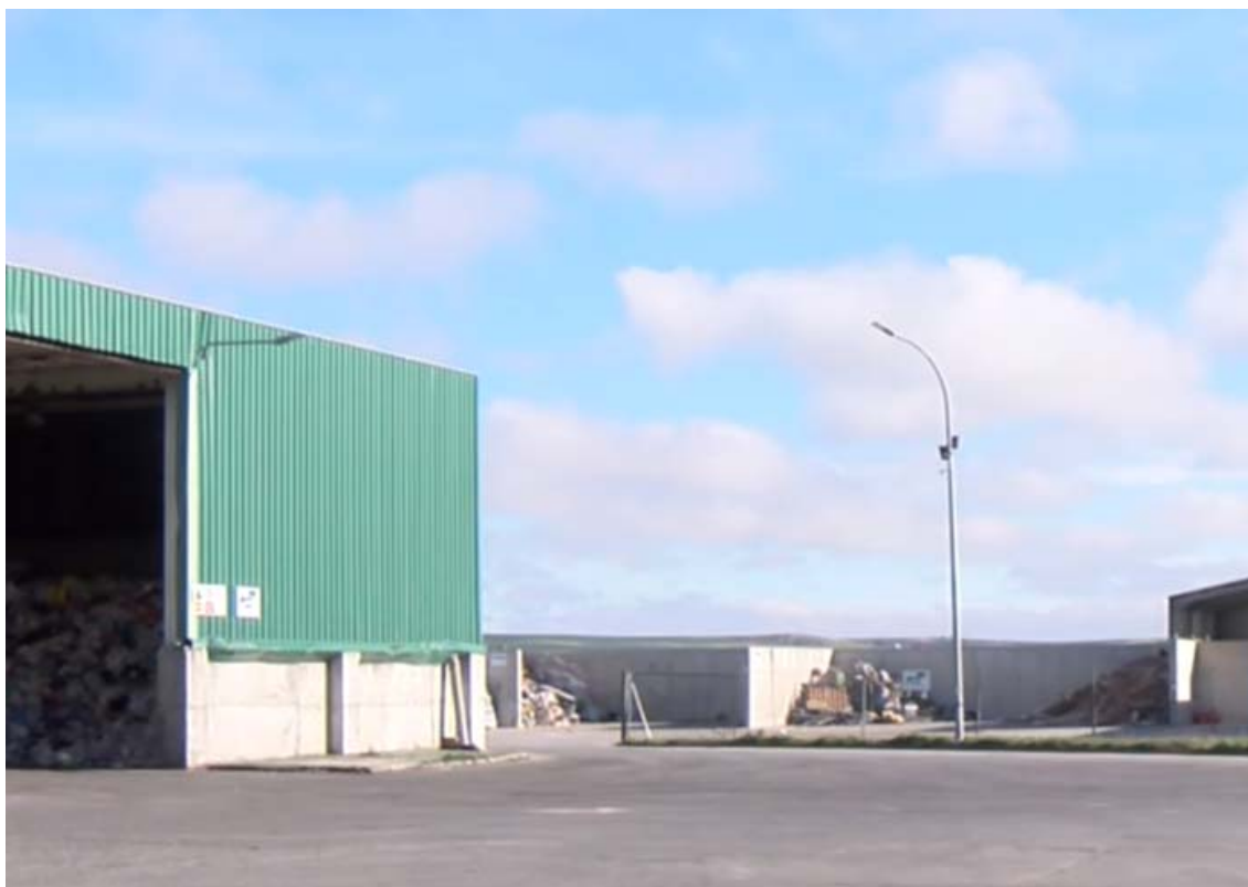
Al fonde de esta instalación, detrás de los muros se ubicará la nueva nave.
