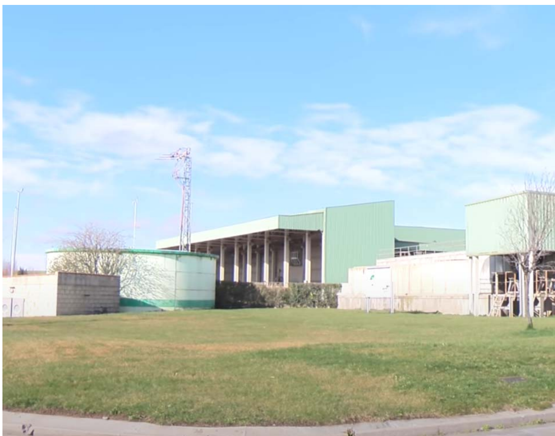
Depósito de agua desde el que se abastecerá a la nave.
